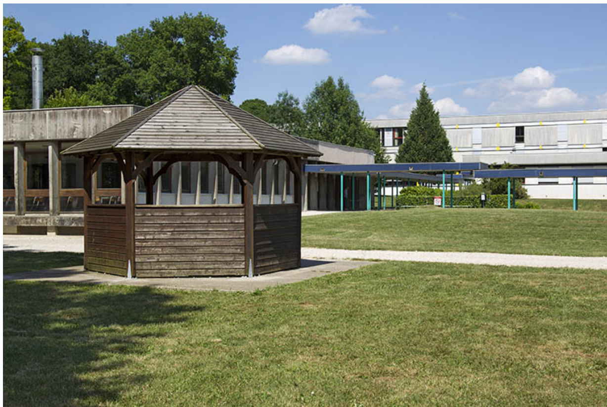
Kiosque à l'angle sud-ouest de la cantine.
