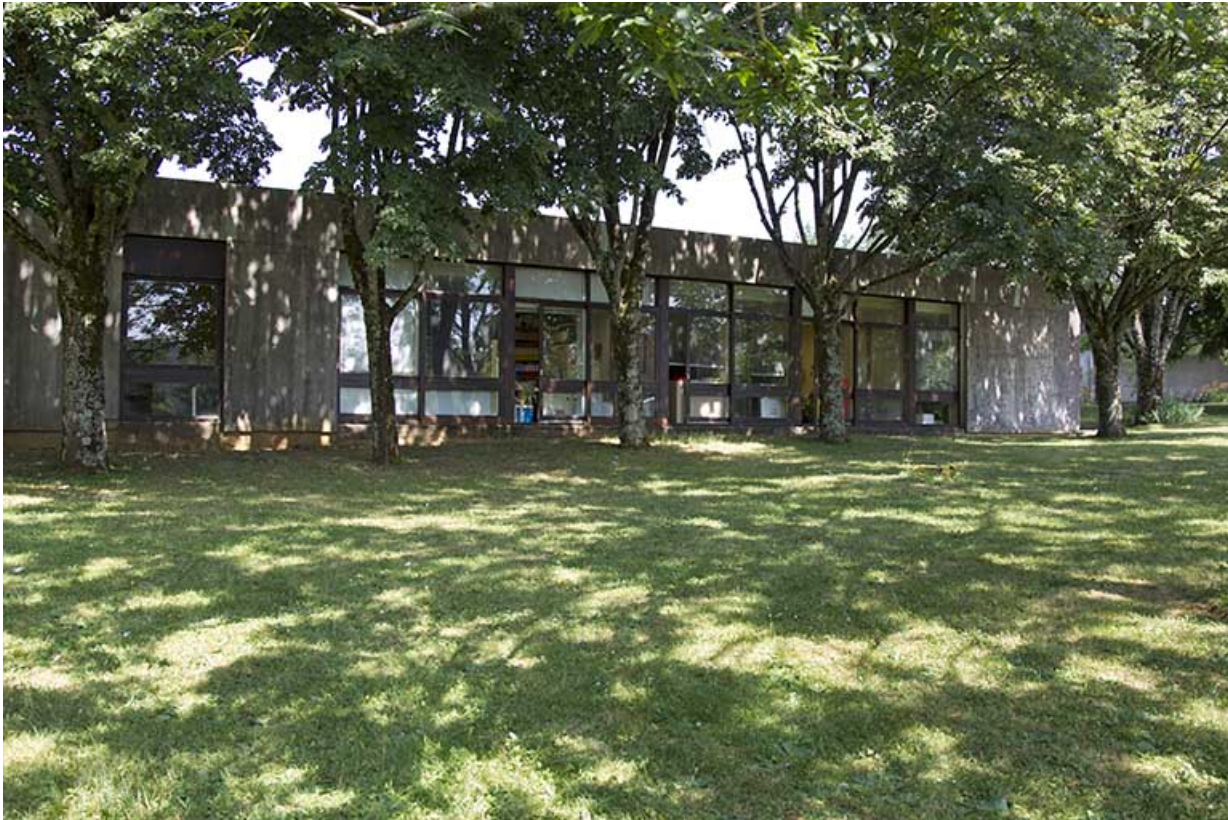
Façade postérieure - ouest - de l'administration.
