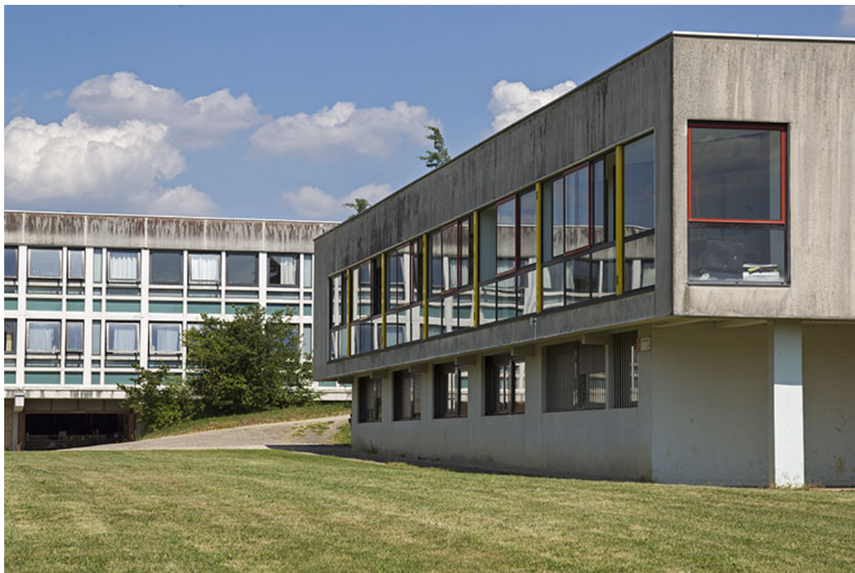
Angle nord-ouest du bâtiment d'internat de filles.
