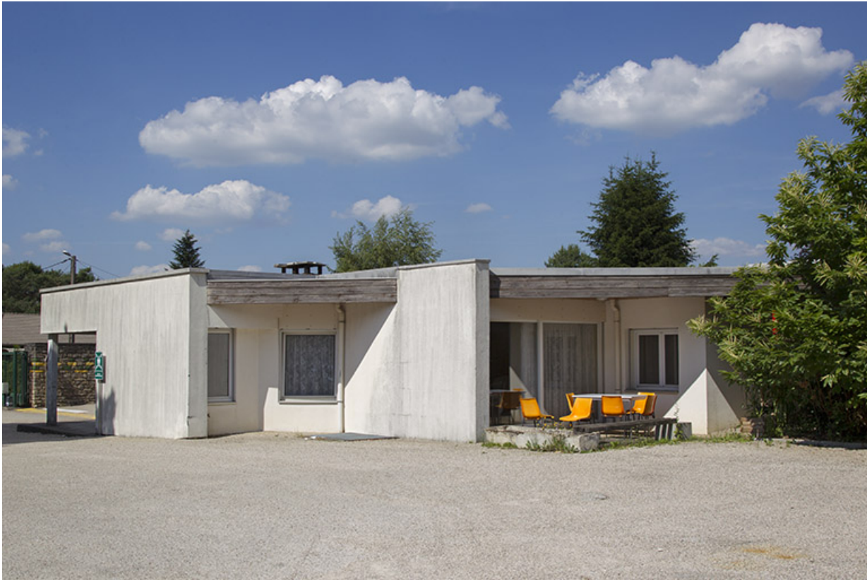
Façade postérieure ouest de la loge.
