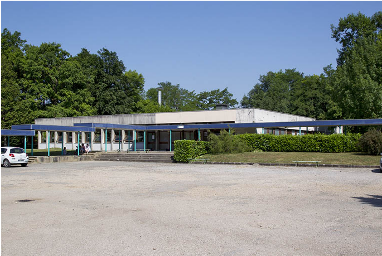
Façade sud de la cantine.
