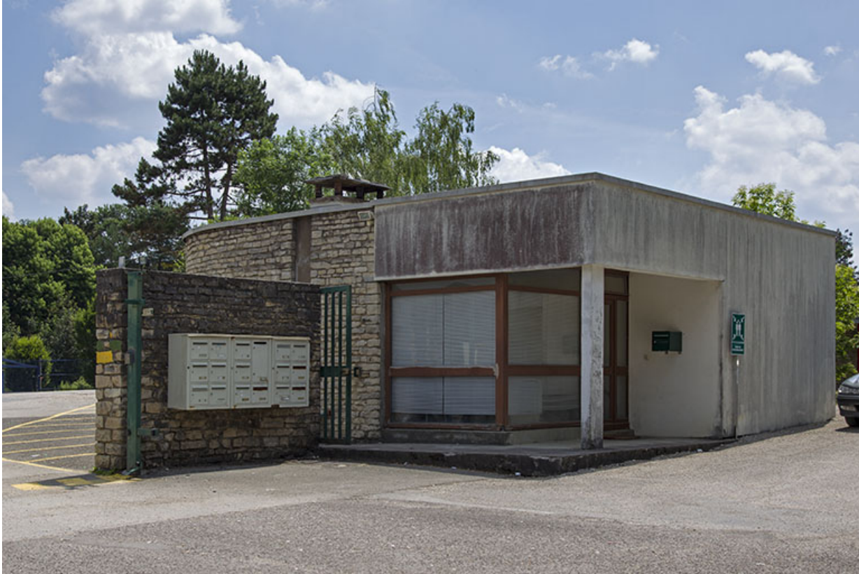
Loge d'entrée vue du nord-ouest.
