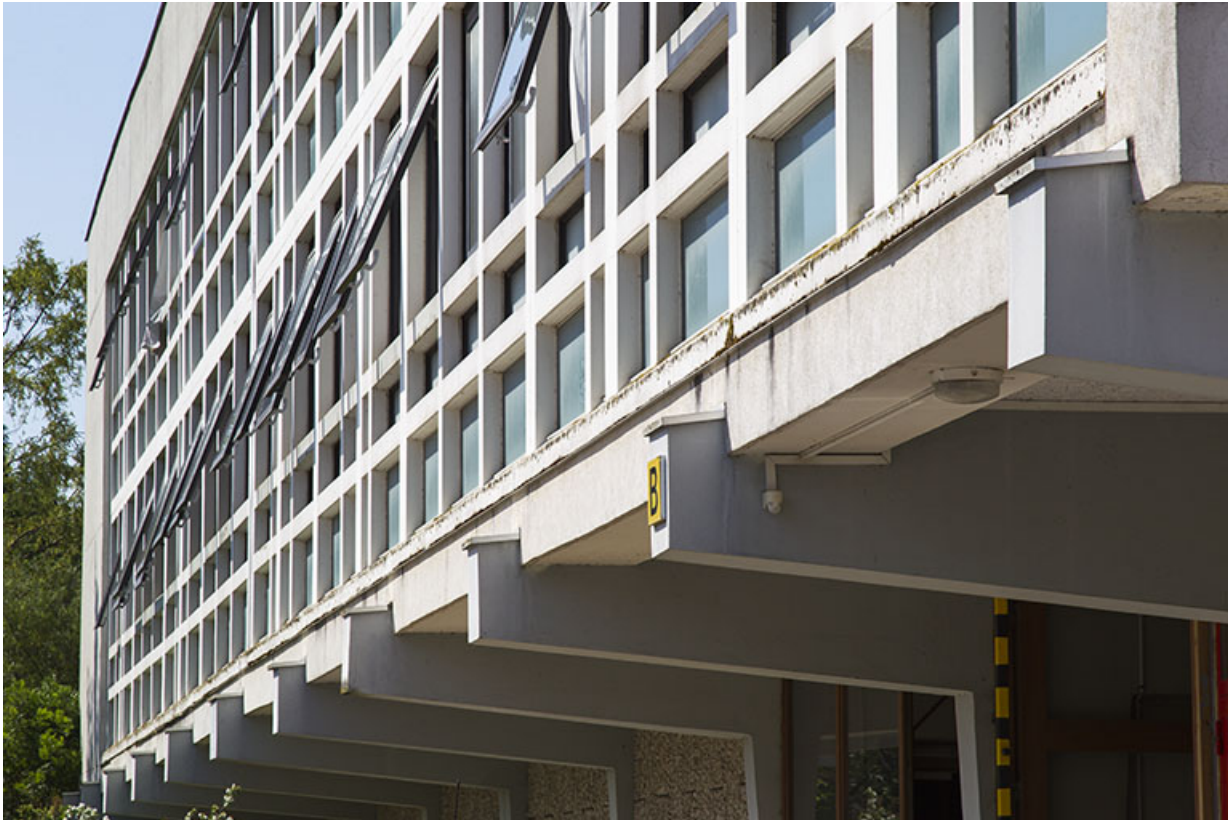
Détail de façade postérieure - ouest - de l'externat.
