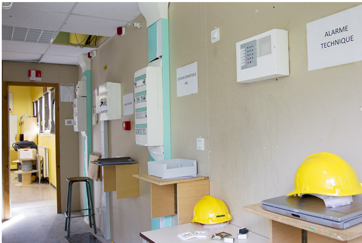
Intérieur de l'atelier des formations en électrotechnique.
