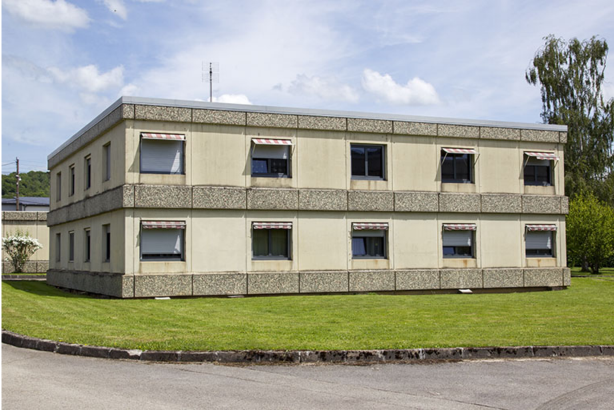
Façade sud-ouest et pignon nord-ouest des logements.
