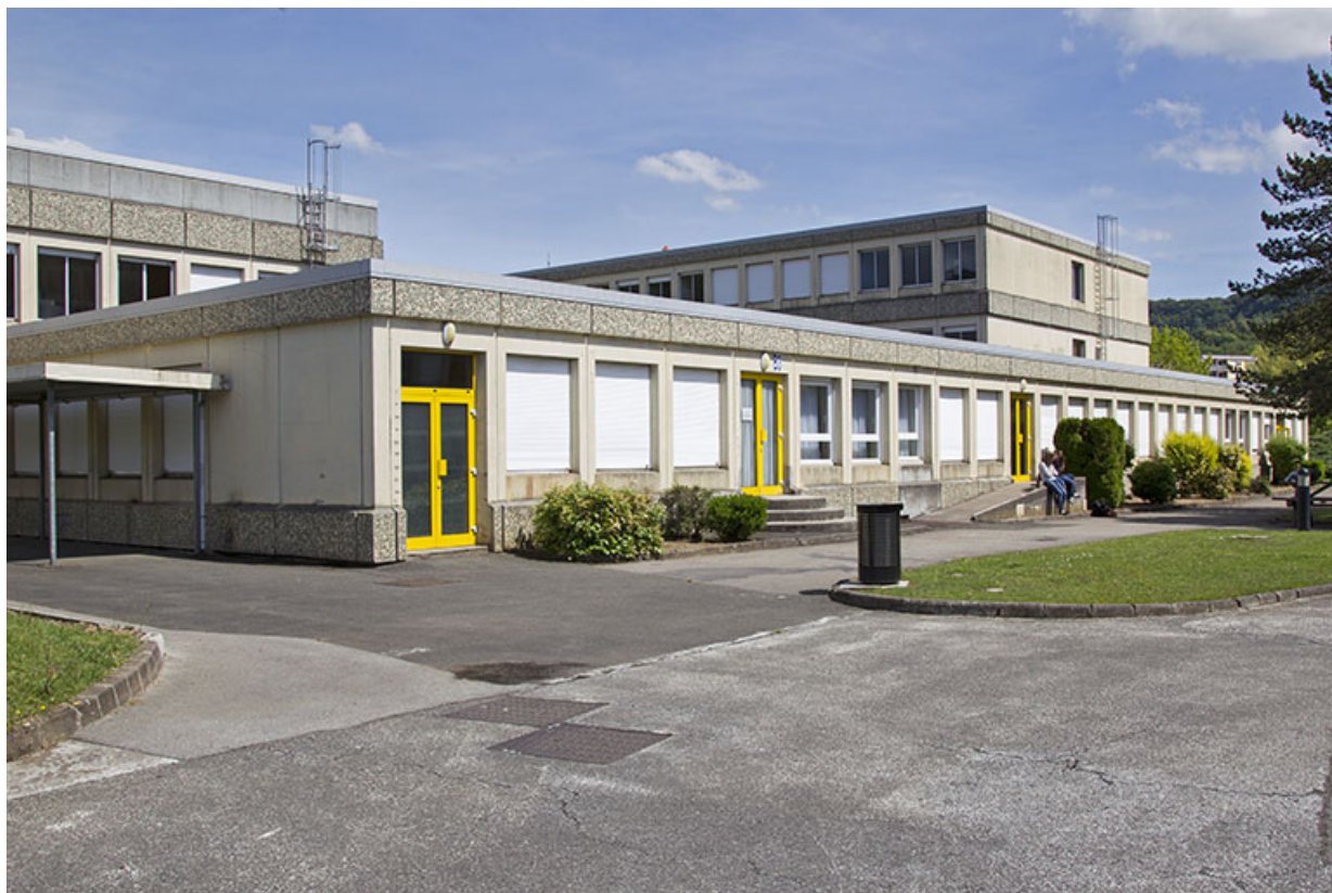
Façade ouest du bâtiment d'enseignement bio services.
