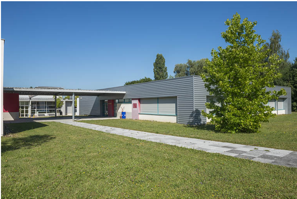
Angle sud-est du bâtiment de maintenance.(ex-Léger)
