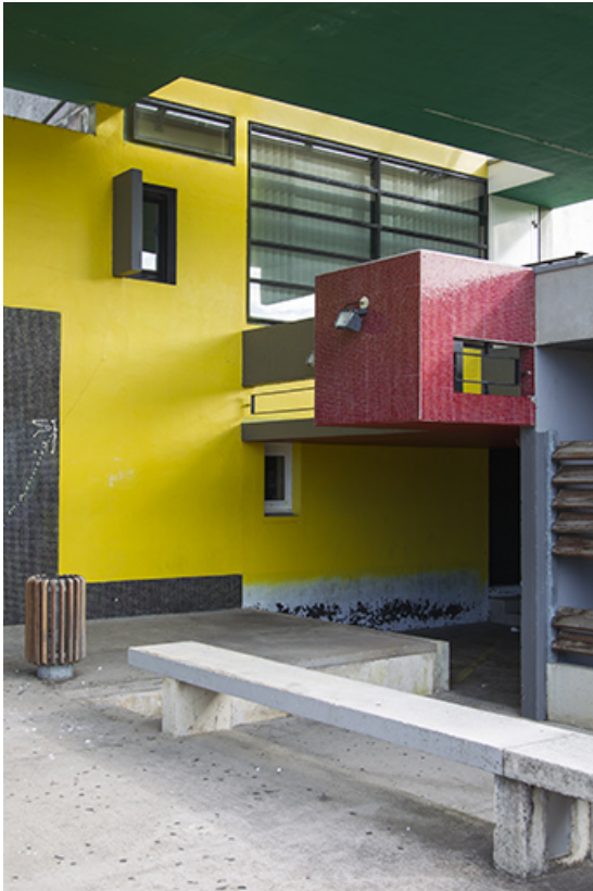
Détail constructif à droite de l'entrée.
