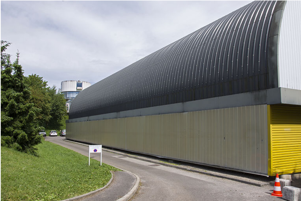
Vue postérieure du gymnase, angle nord-ouest.
