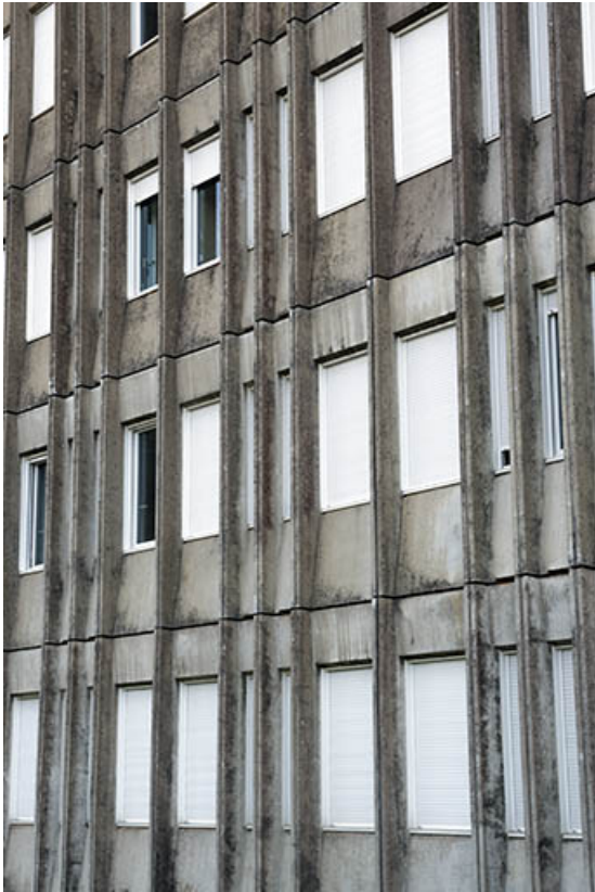
Détail de la façade de l'internat.
