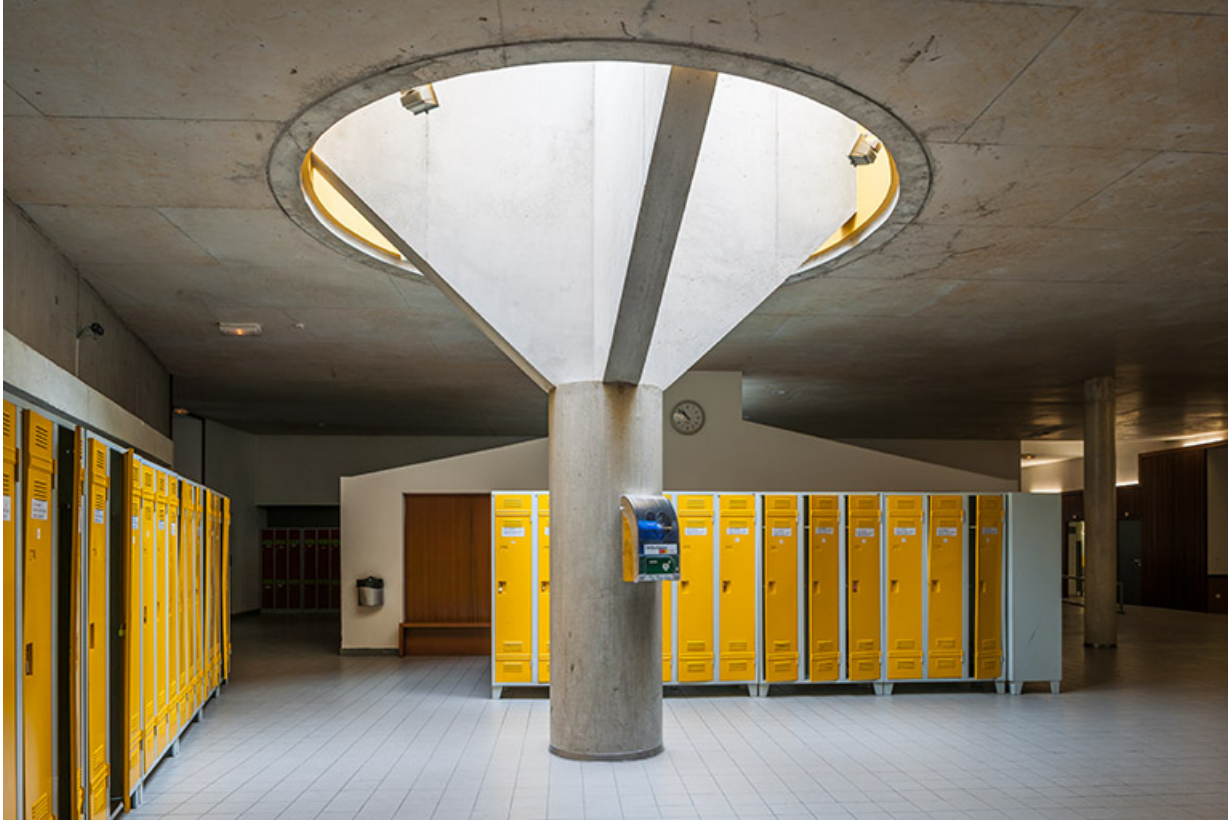
Forum souterrain (sous la cour centrale).
