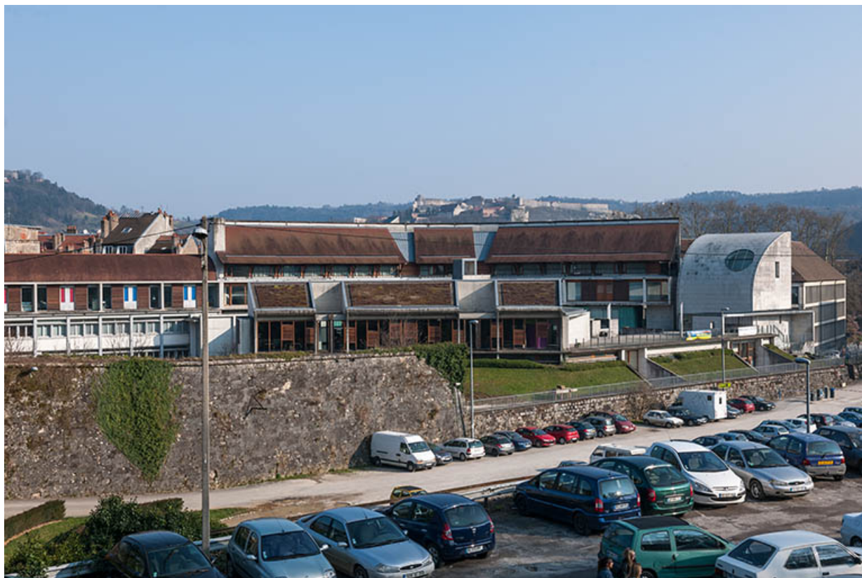
Vue d'ensemble des parties sud depuis l'ouest.
