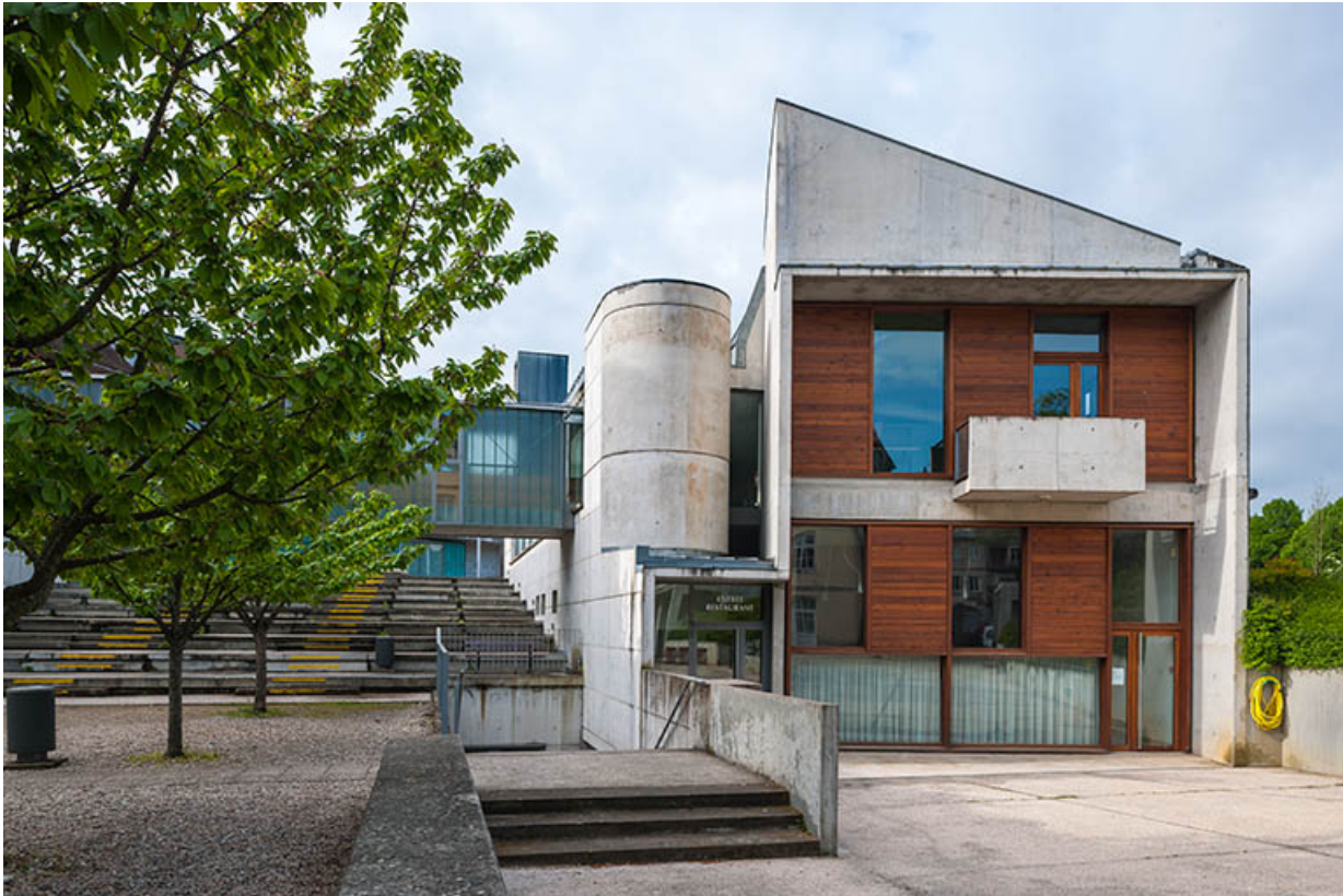
Pignon nord du restaurant d'application.
