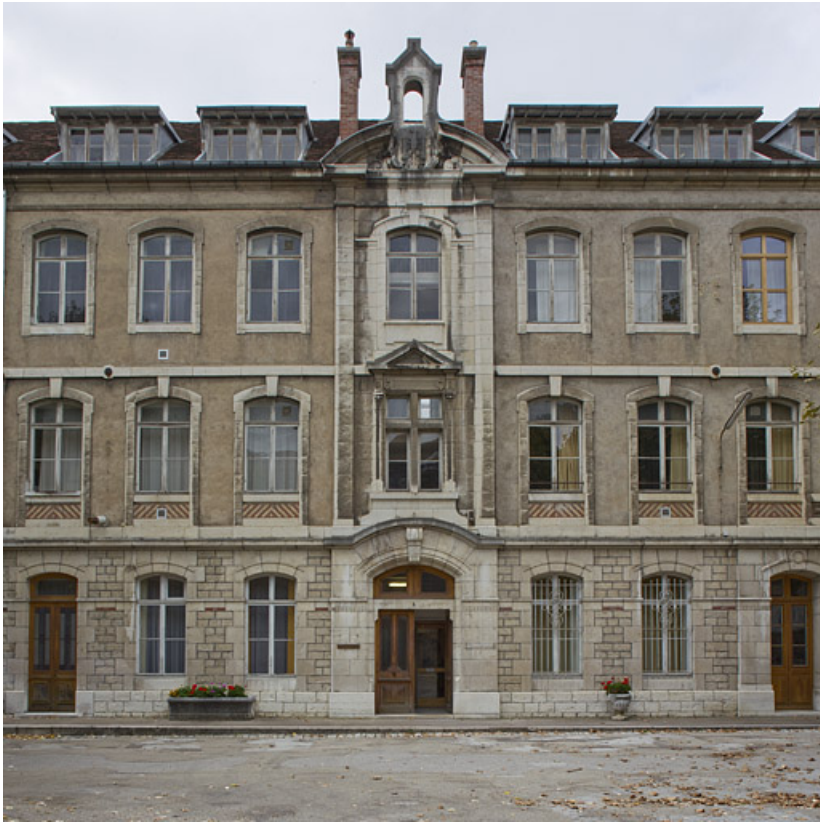
Façade antérieure du bâtiment Ducat.
