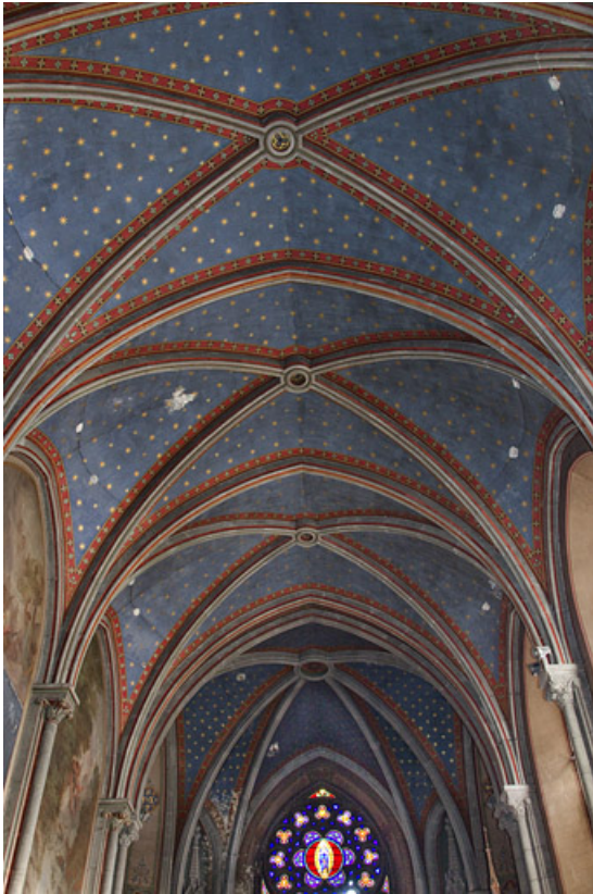
Voûtes de la nef de la chapelle.
