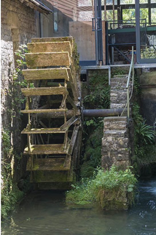
La roue hydraulique en-dessous.
