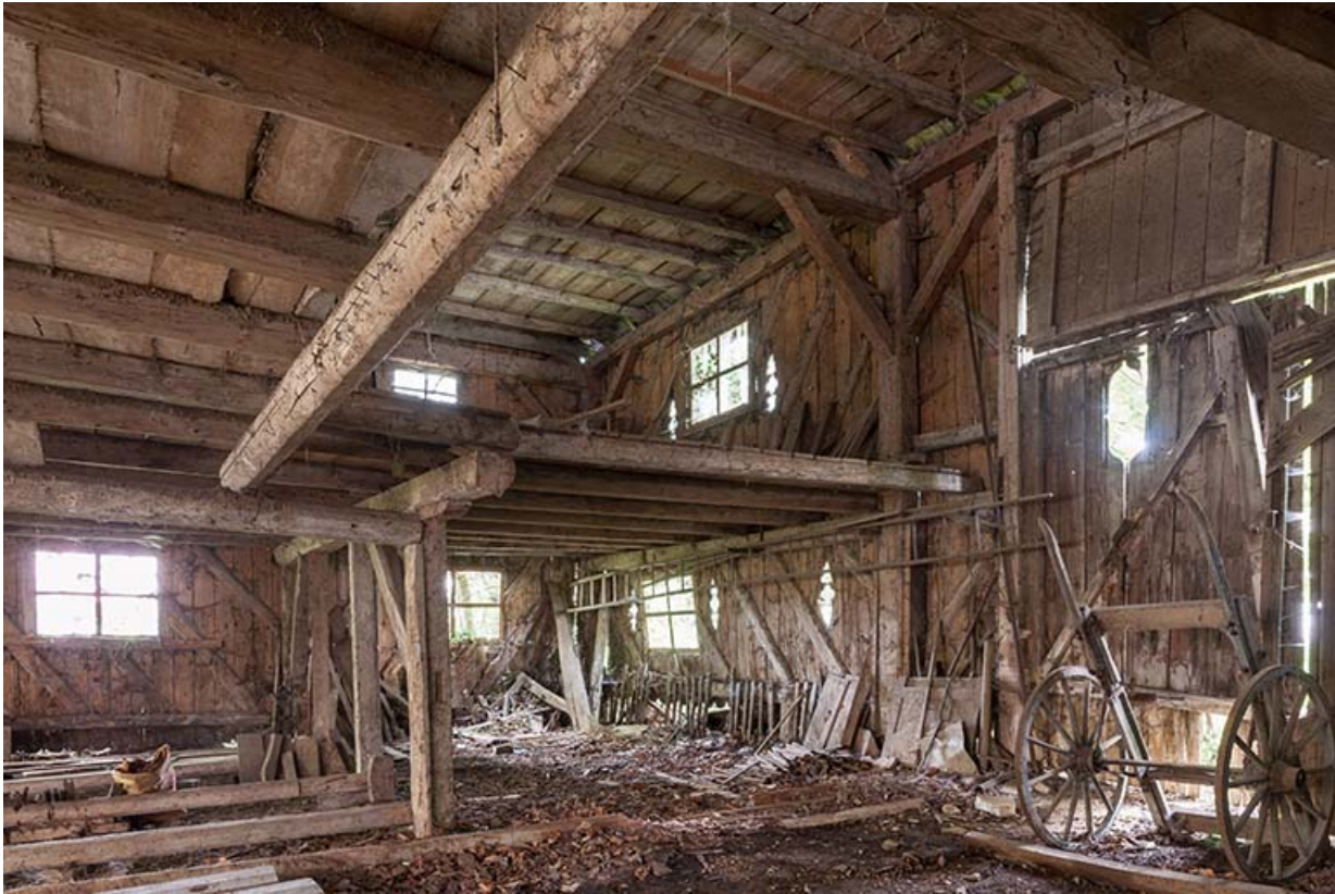
Magasin industriel. Vue depuis l'ouest.
