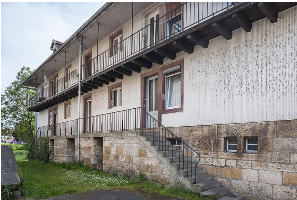
Logement oriental. Détail de la façade nord.
