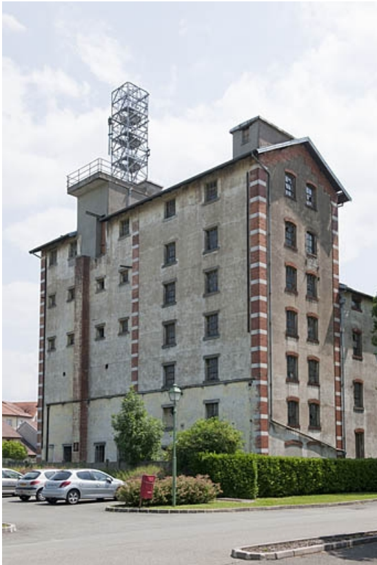
La malterie vue depuis le nord-ouest.
