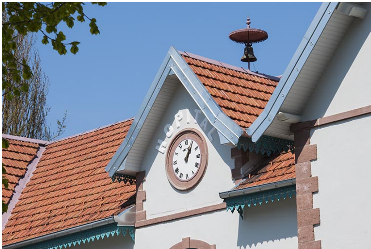
Façade antérieure. Détail du pignon.
