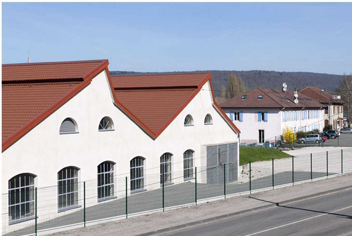
Pignons de la centrale hydroélectrique.
