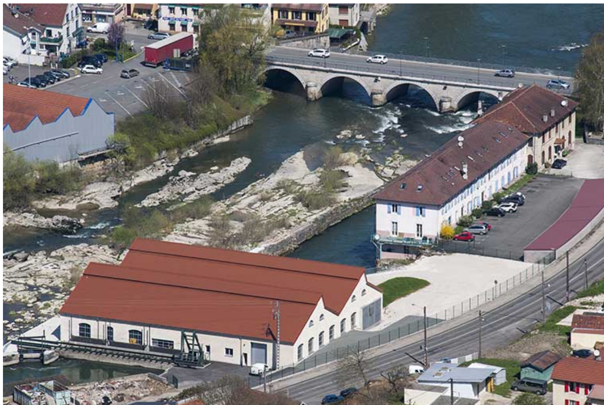
Bâtiments de bureaux en aval du site.
