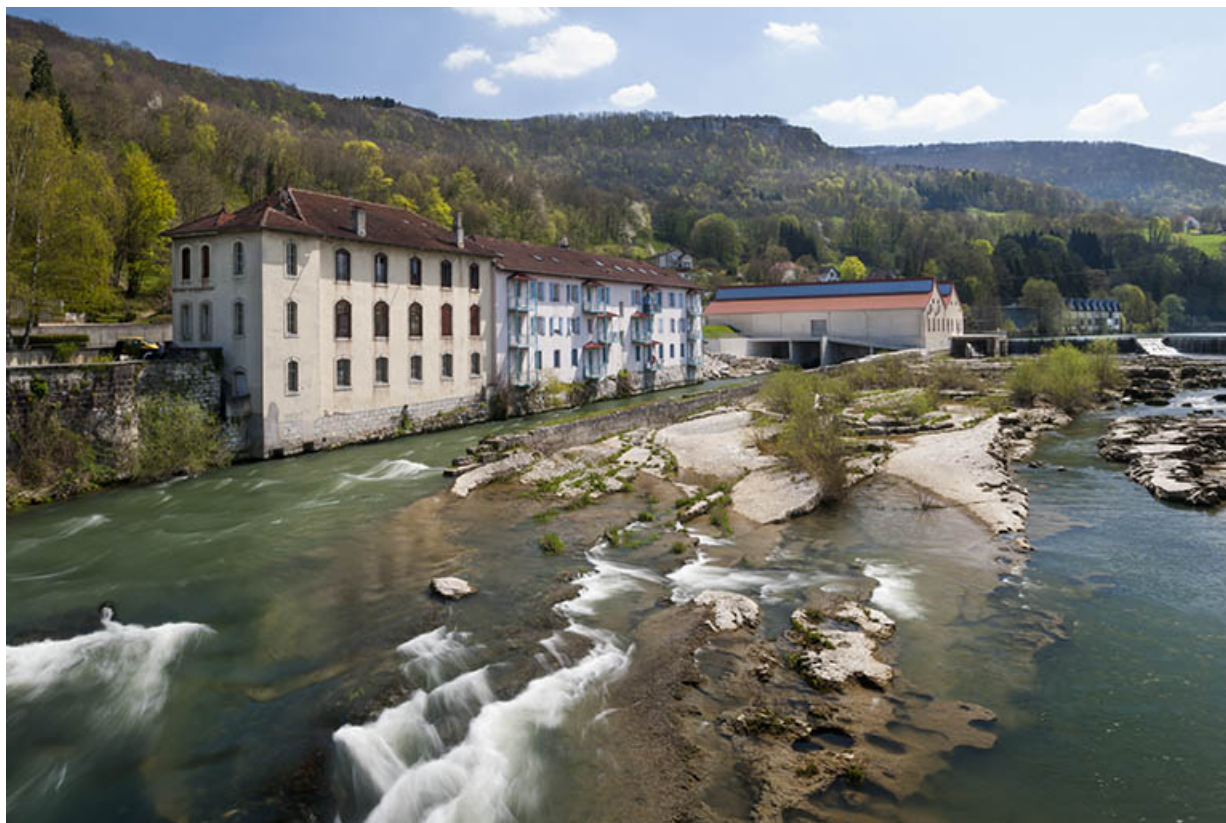
Usine rive droite depuis le pont.
