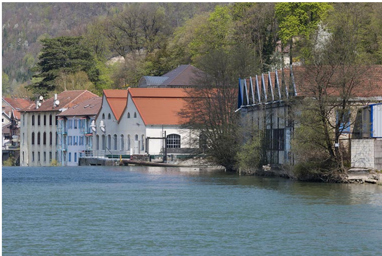
Vue de l'usine rive droite depuis l'amont.
