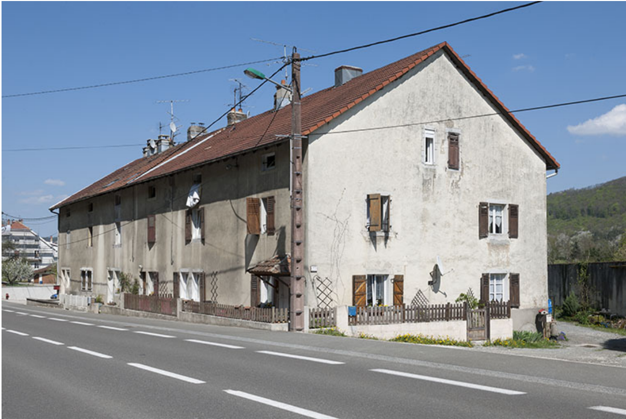
Logement d'ouvriers vu de trois quarts droite.
