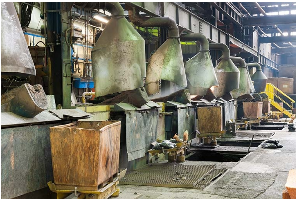
Batterie de fours à induction (1).
