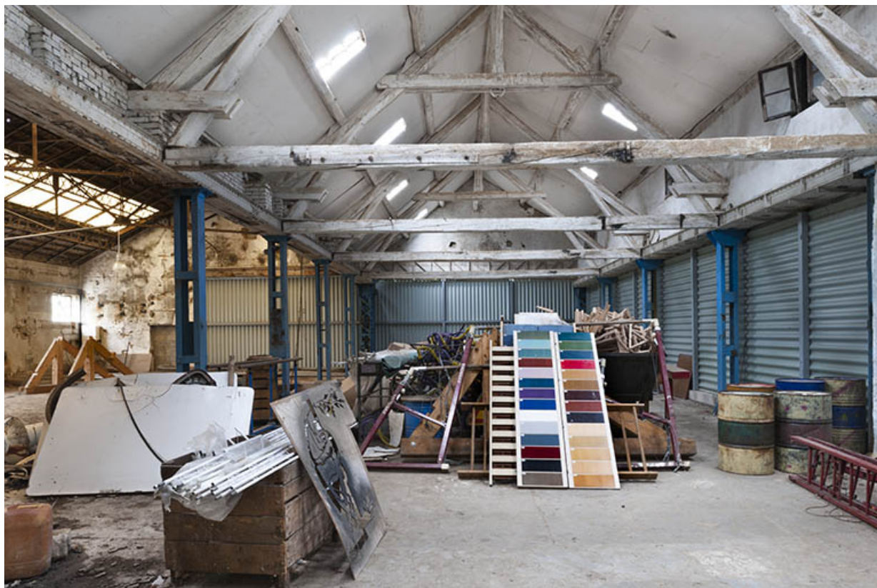
Atelier d'usage. Vue intérieure.
