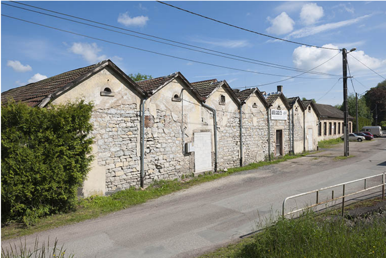
Murs-pignons de l'atelier de filature.
