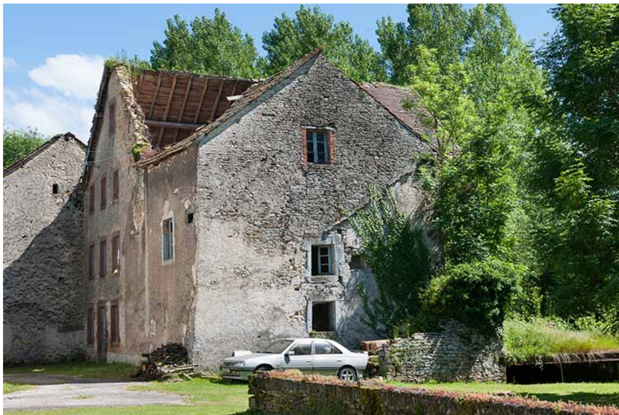
Le moulin depuis le nord-ouest.
