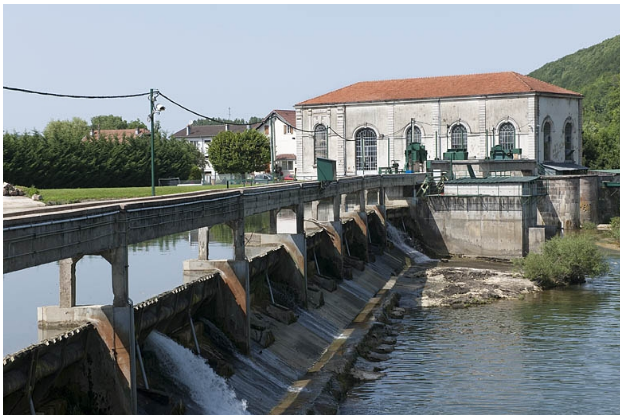
Les déversoirs du barrage et la centrale.
