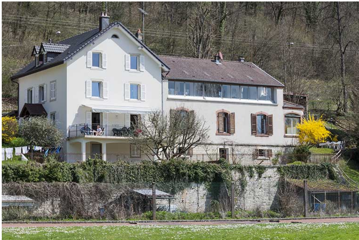
Façade ouest vue de trois quarts gauche.
