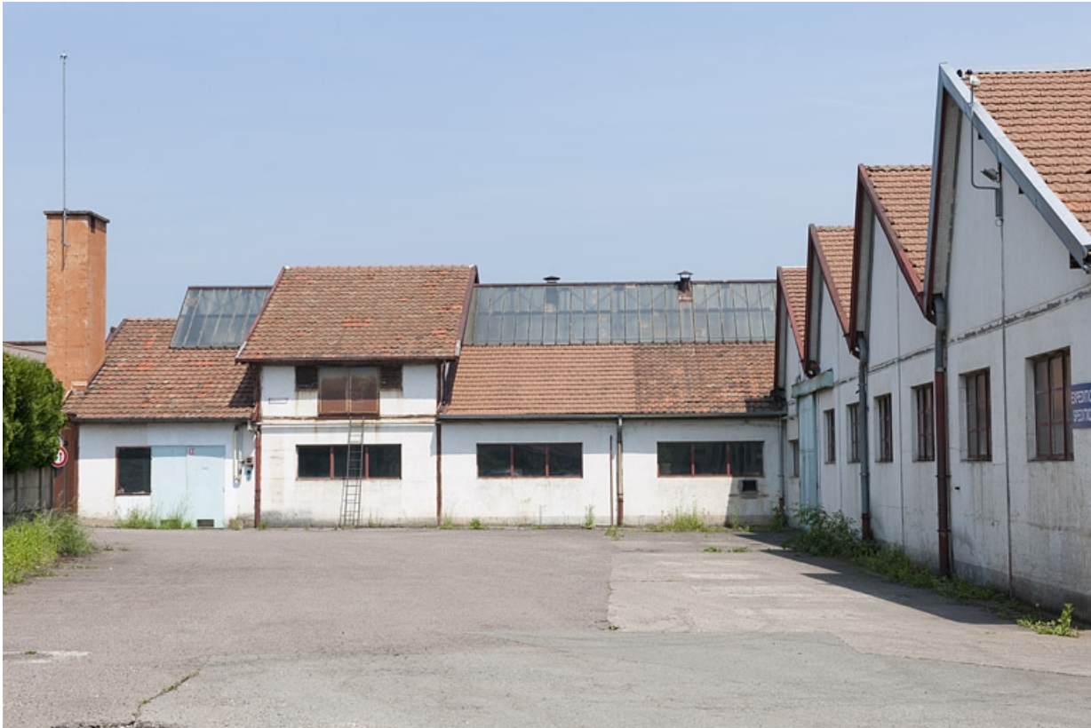
Façade et pignons d'ateliers de fabrication.
