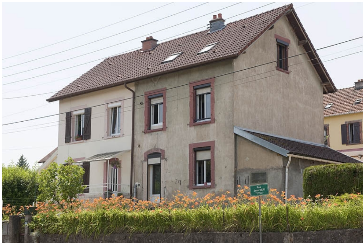
Maison jumelée à entrées contiguës.
