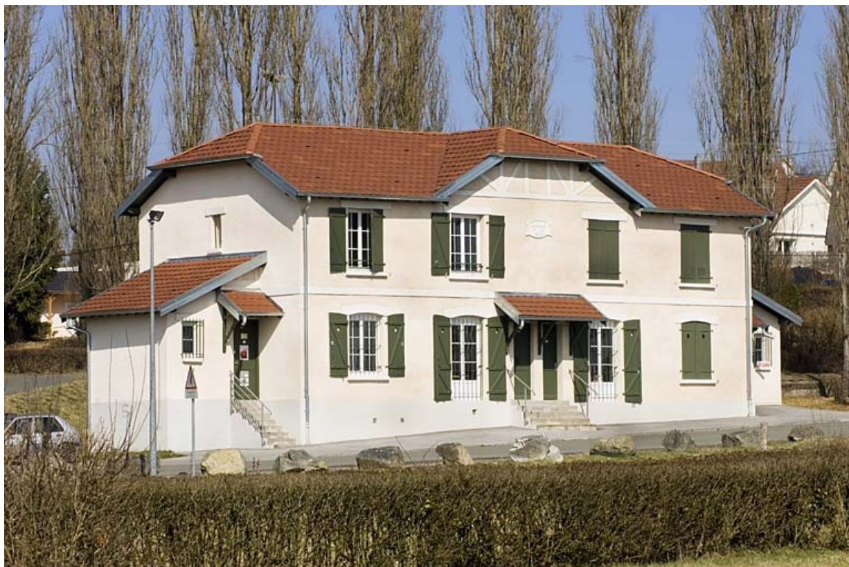
Habitation à 4 logements vue depuis le sud-ouest.
