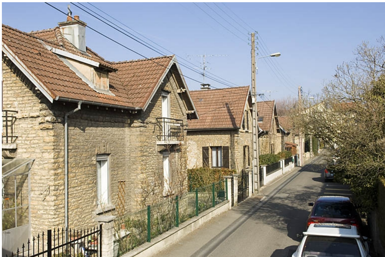
Façades antérieures sur la rue des Fleurs.
