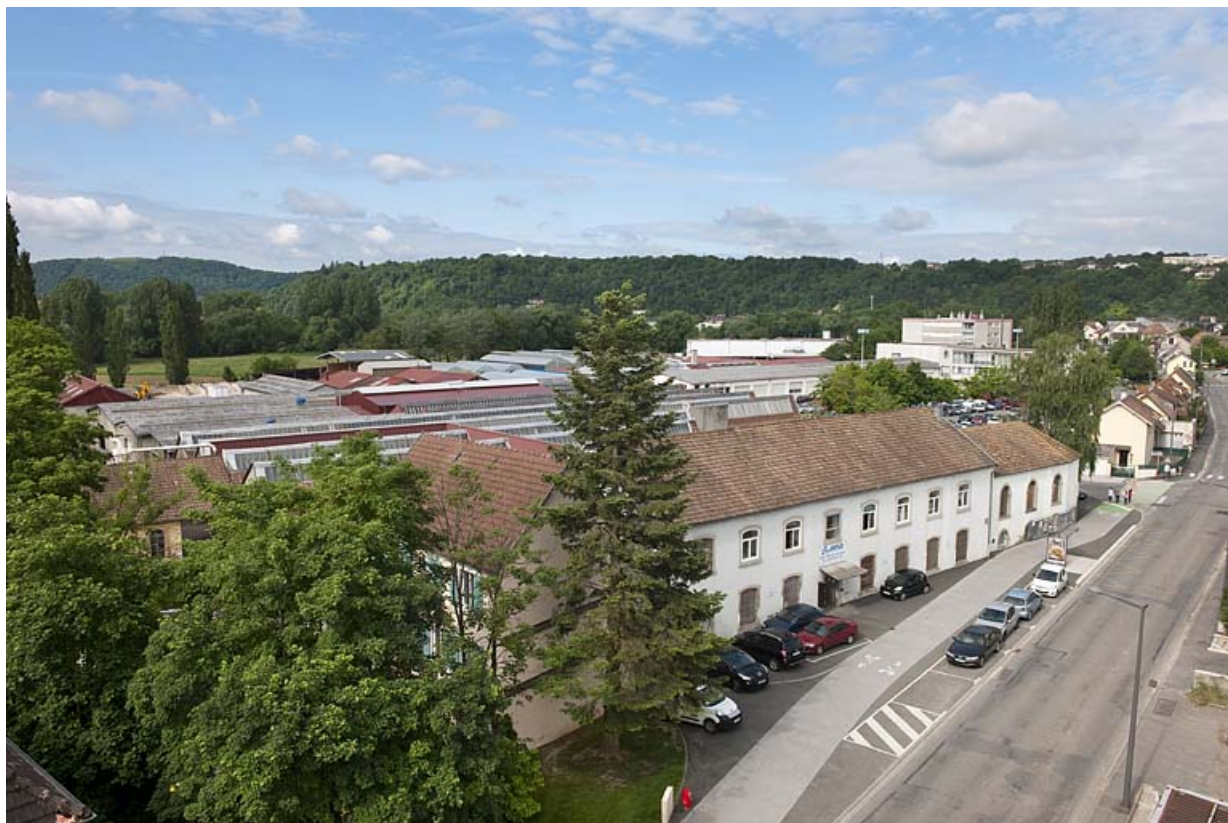
Vue plongeante depuis le nord-est.
