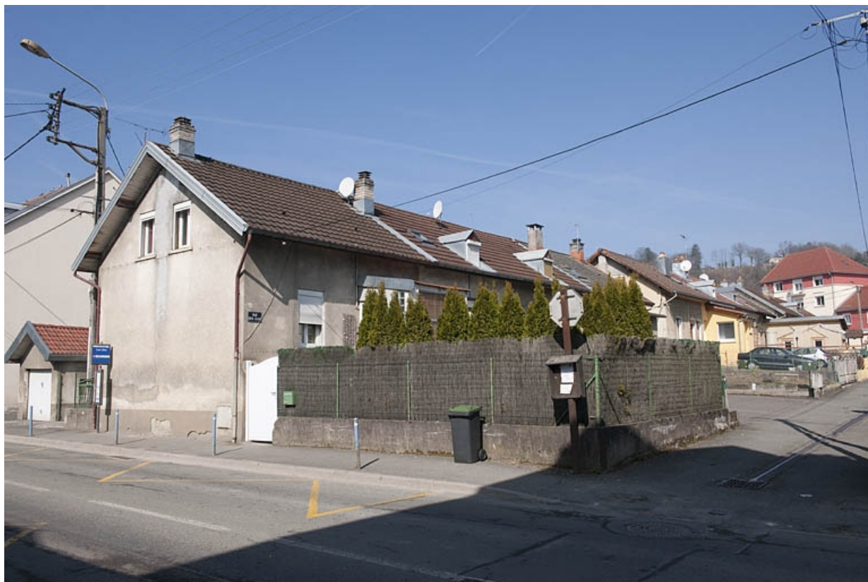
Habitations à 4 logements rue des Lilas.
