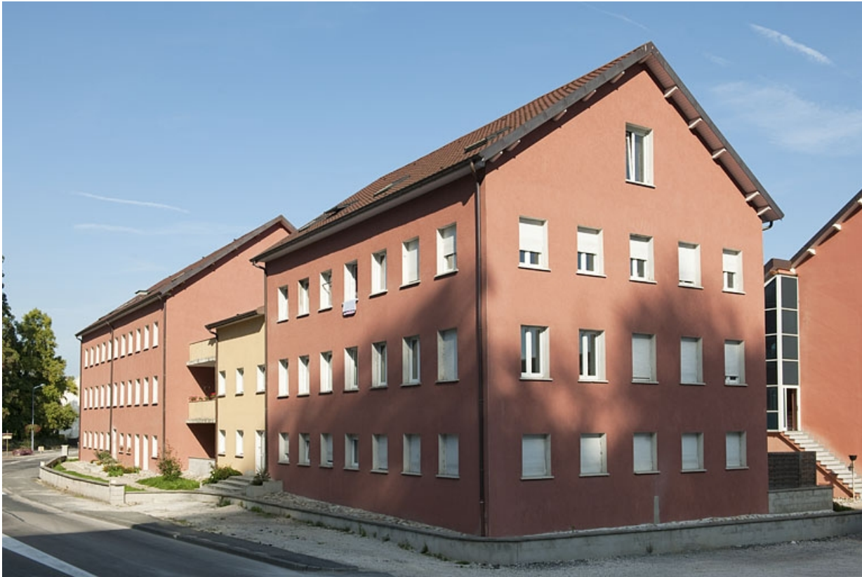
Ateliers de fabrication vus depuis le sud-ouest.
