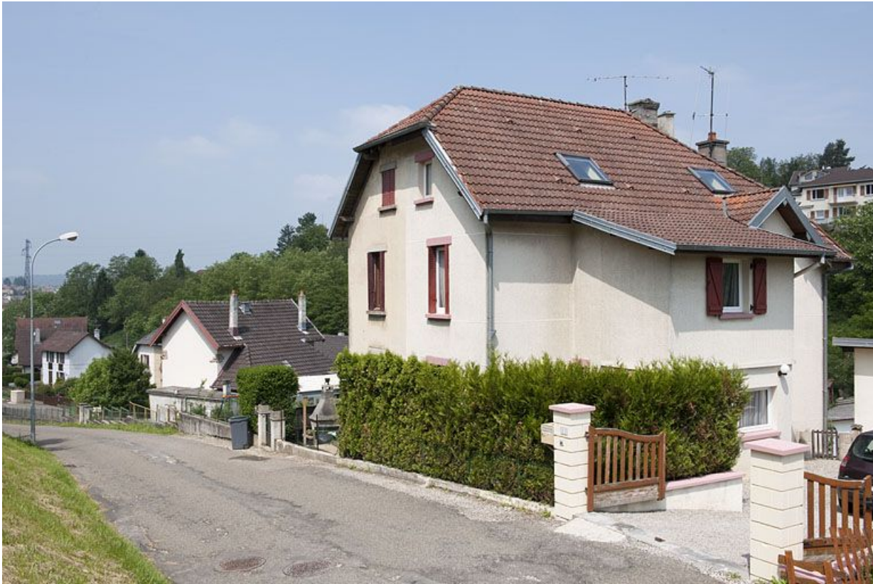
Maison jumelée. Vue de trois quarts droite.
