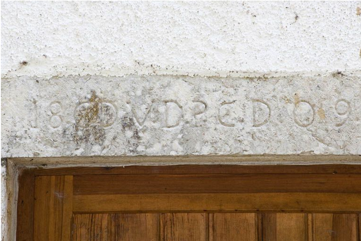
Façade nord du moulin. Linteau gravé.
