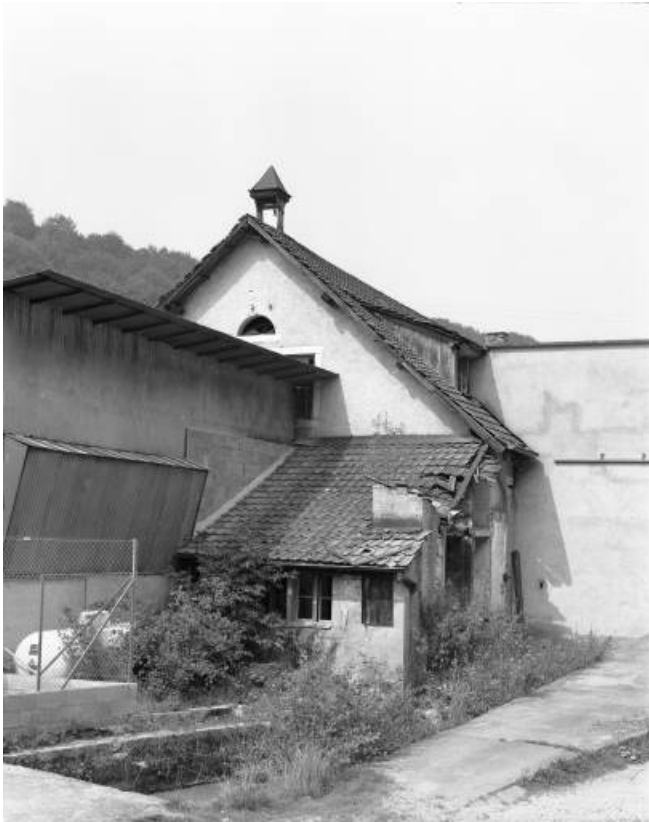
Pignon d'un atelier de fabrication en 1981.
