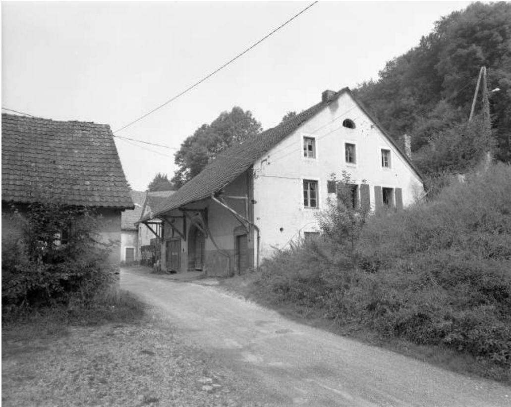
Bâtiment agricole en 1981.
