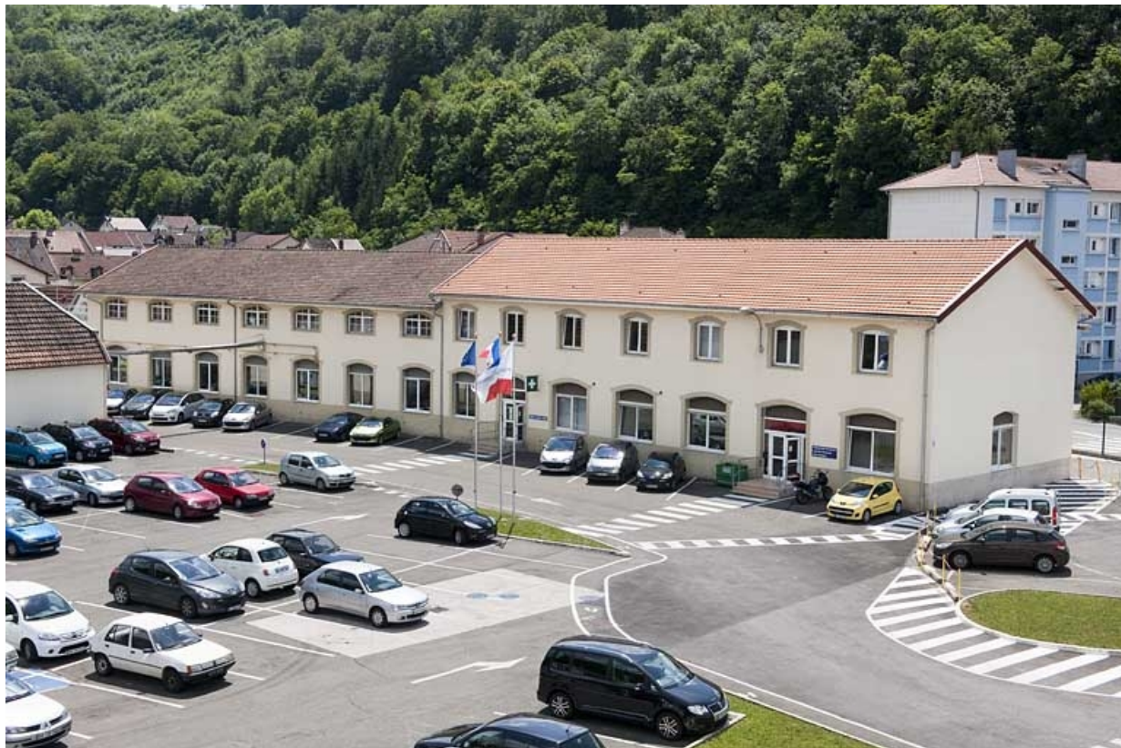
Bâtiment des bureaux depuis le nord-est.
