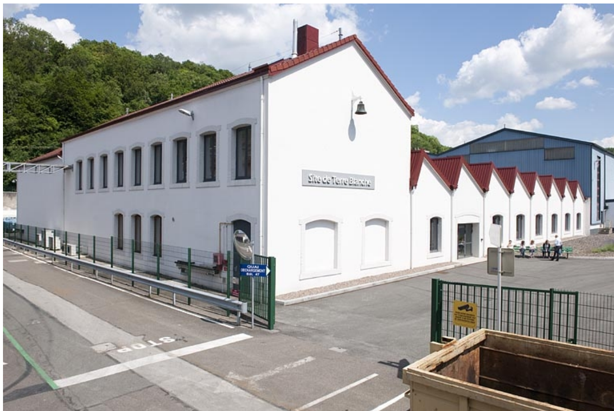
Bâtiment de bureaux (?) et centre d'archives.
