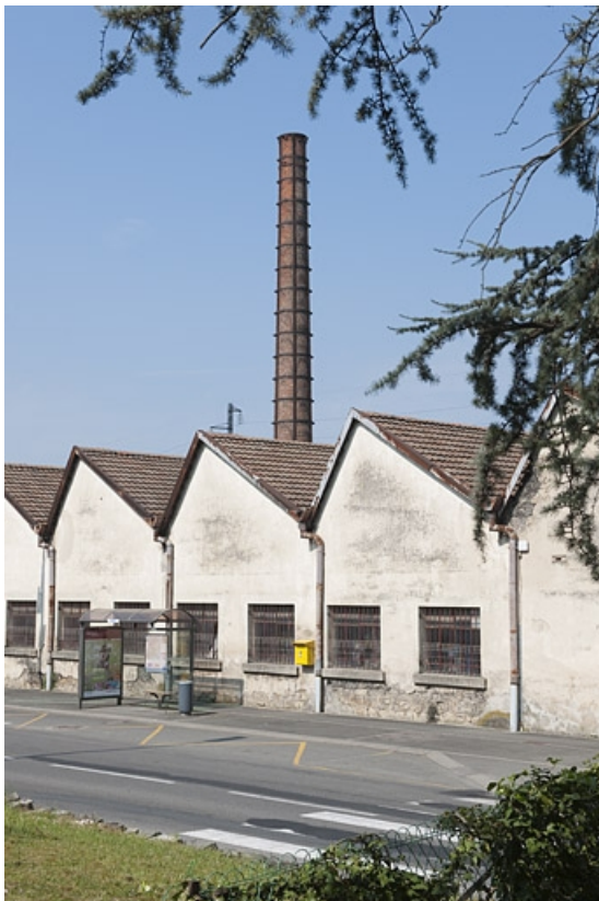
Vue rapprochée de l'atelier de laitonnerie.
