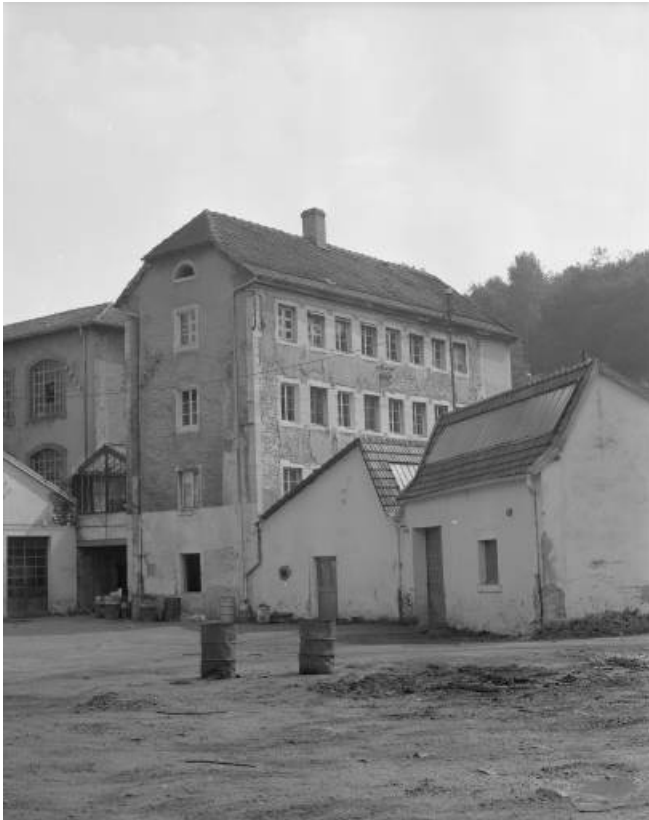
Elévation d'un ancien atelier en 1981.
