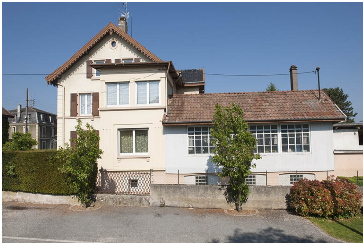
Pignon et façade sud de l'atelier.
