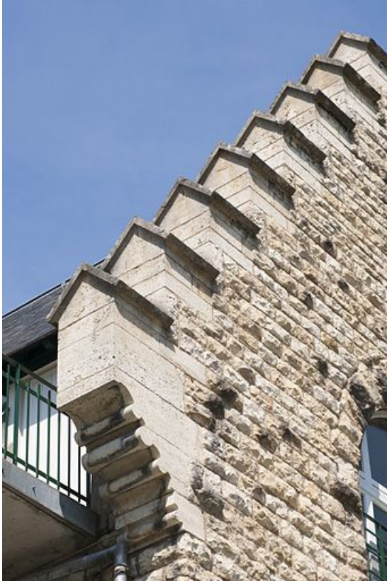
Façade postérieure. Détail des redents du pignon.
