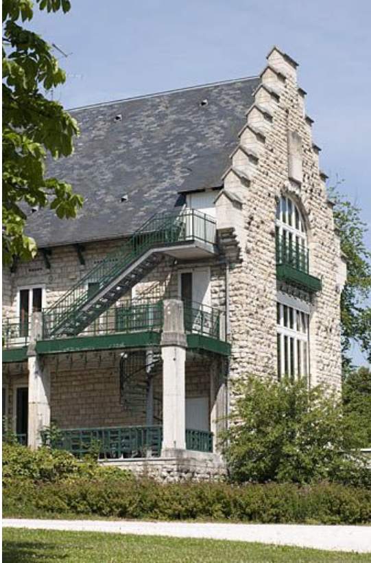
Façade postérieure. Pignon vu de trois quarts.
