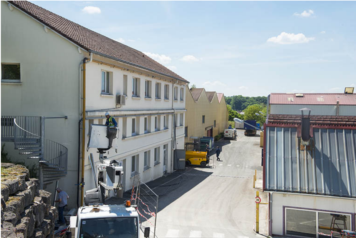
Bâtiment administratif et atelier de fabrication.
