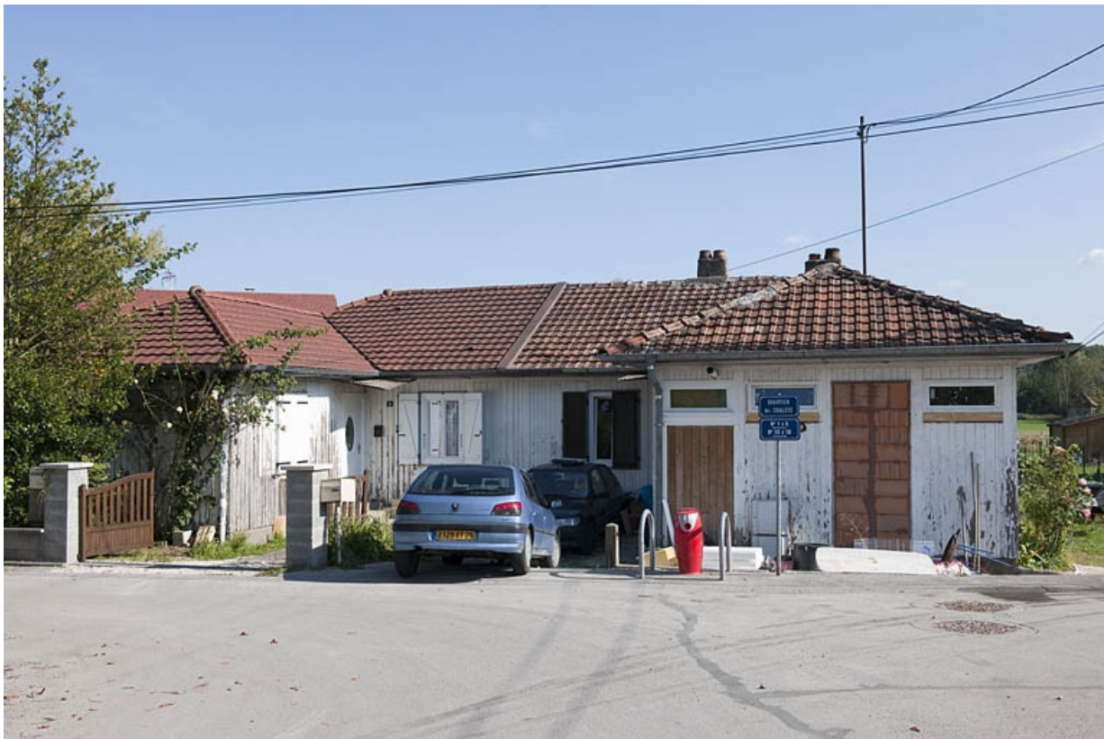
Maison jumelée vue de face.
