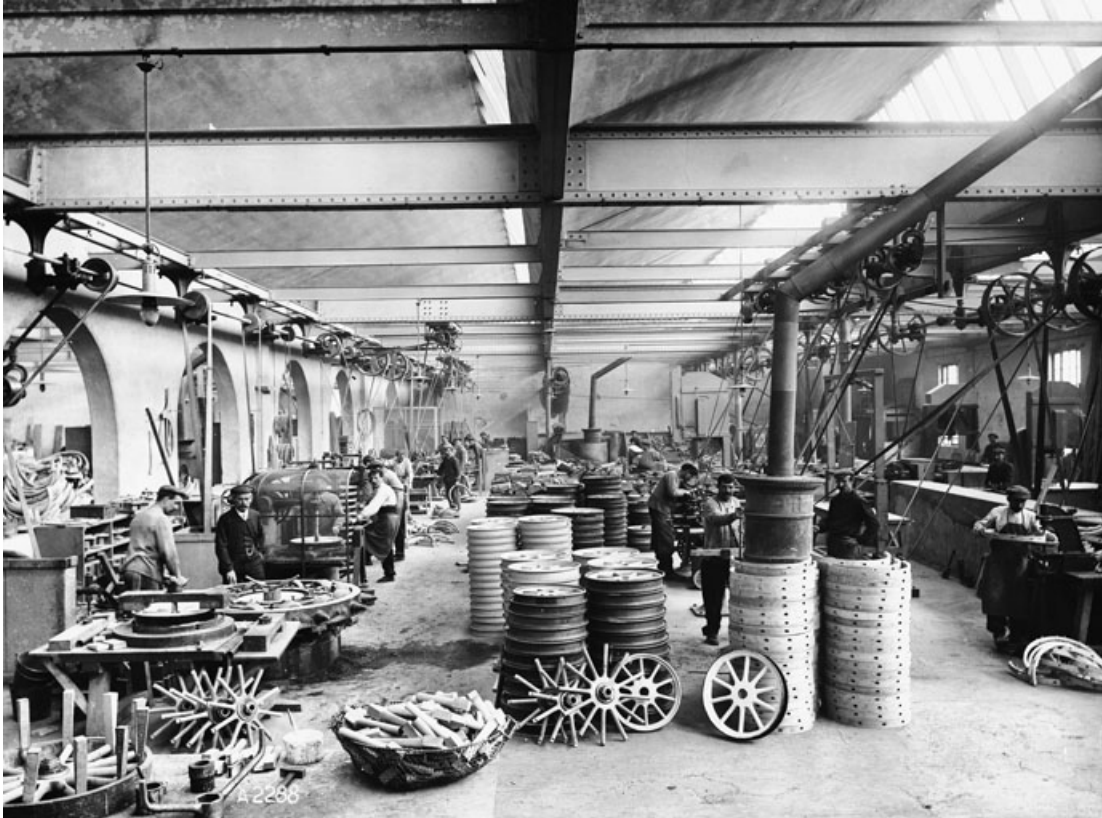
Usine d'Audincourt (?). Atelier de fabrication des roues.
