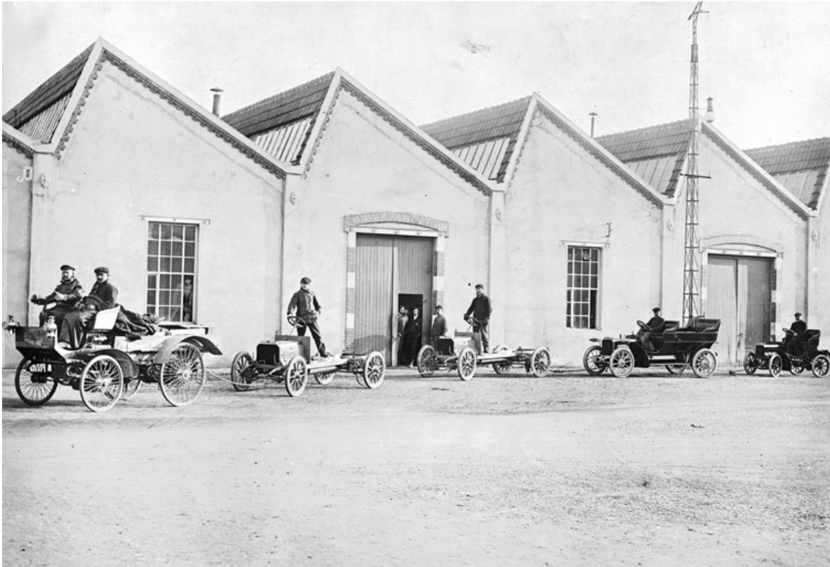
Manutention de châssis devant un atelier.
