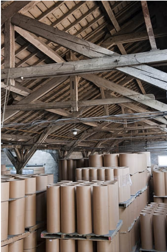
La charpente du magasin industriel (cadrage vertical).
