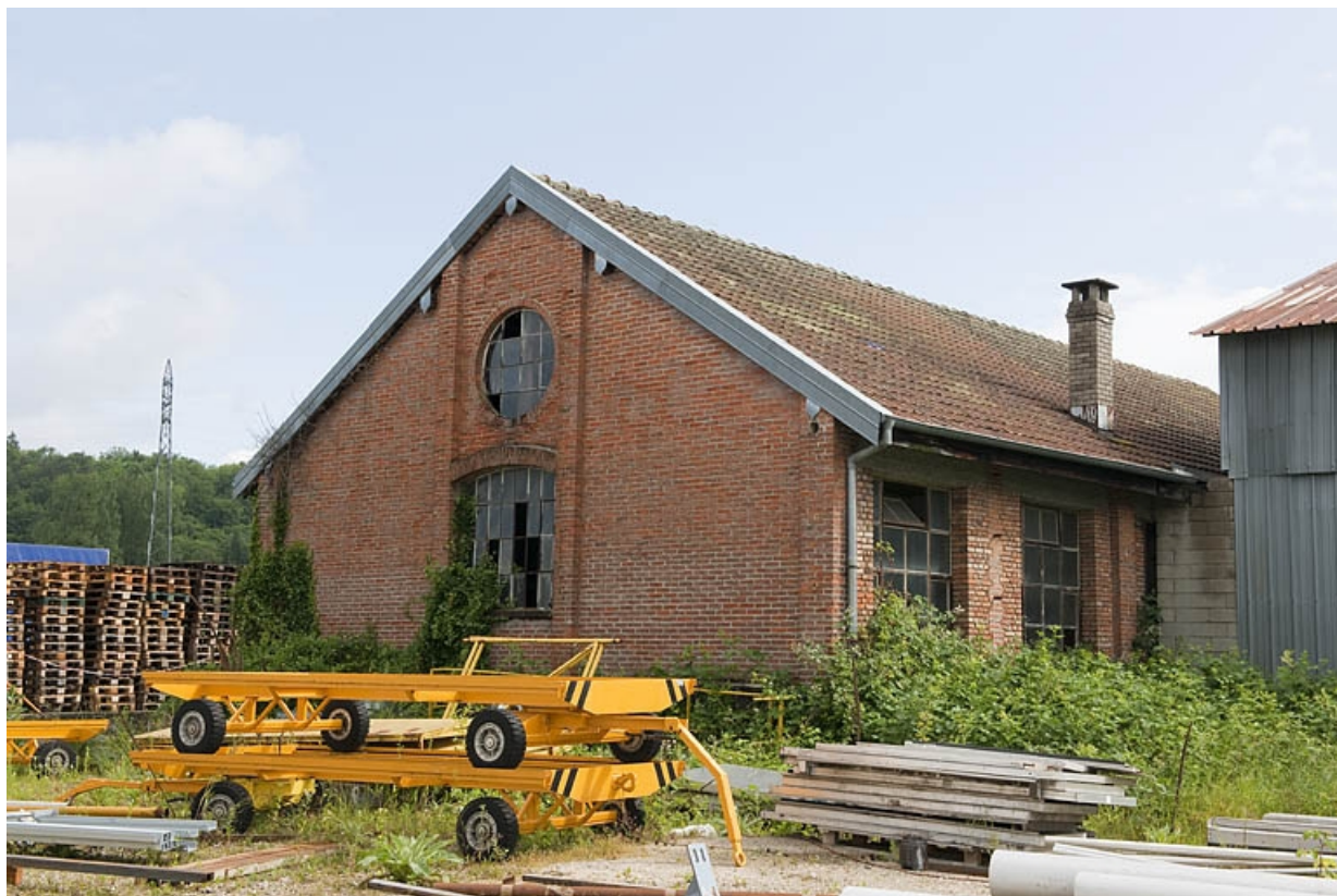
Entrepôt industriel vu de trois quarts arrière.
