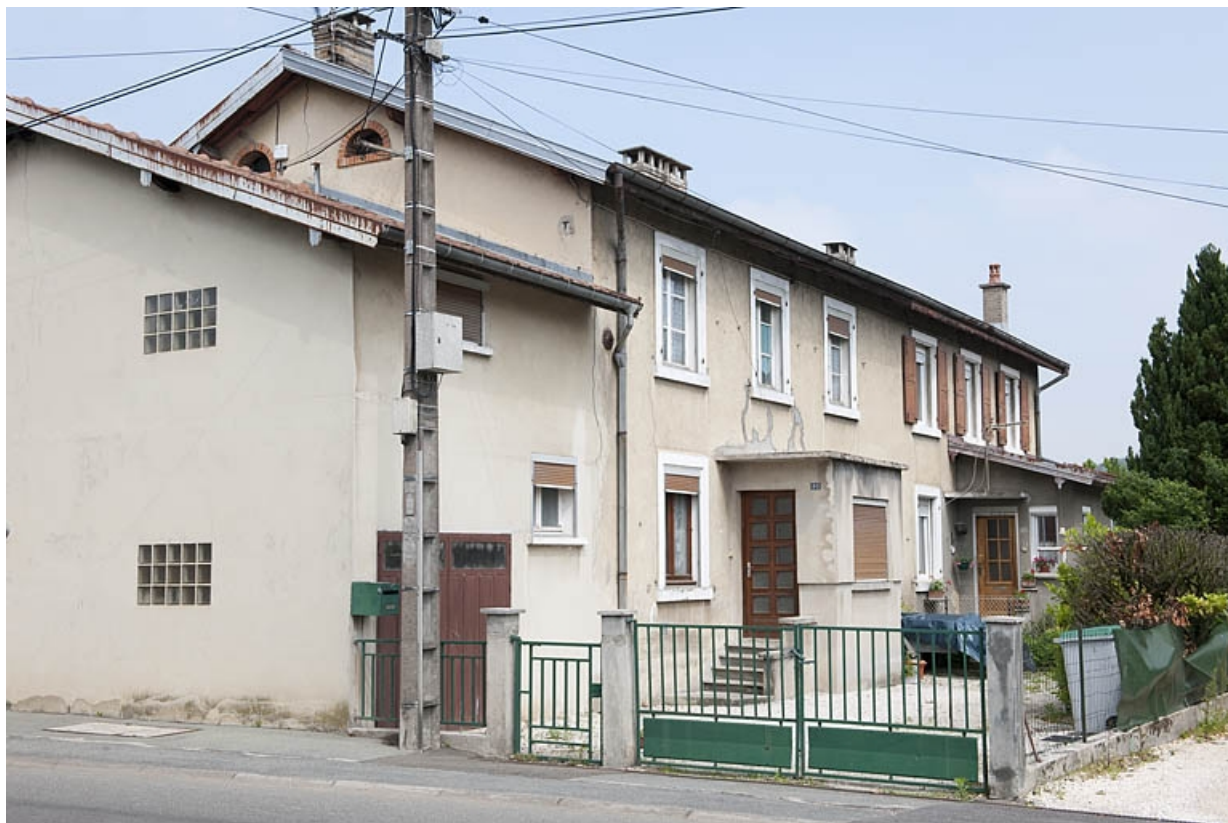
Cité ouvrière. Façade est d'une habitation.
