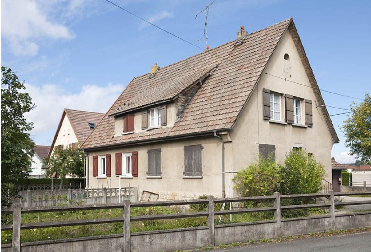
Vue de trois quarts d'une maison.
