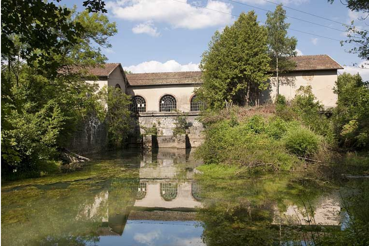
Vue d'ensemble depuis l'aval du bief.
