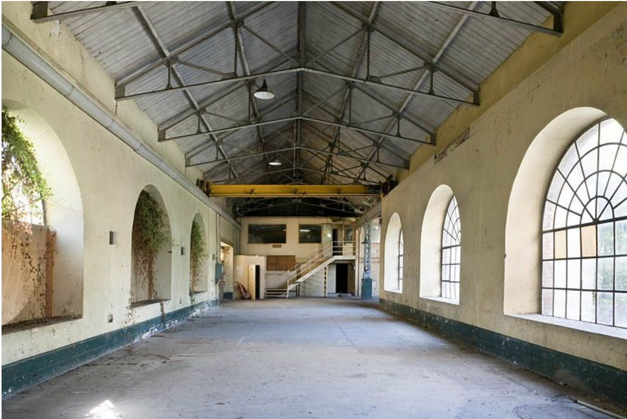
Vue intérieure de la salle des turbines.
