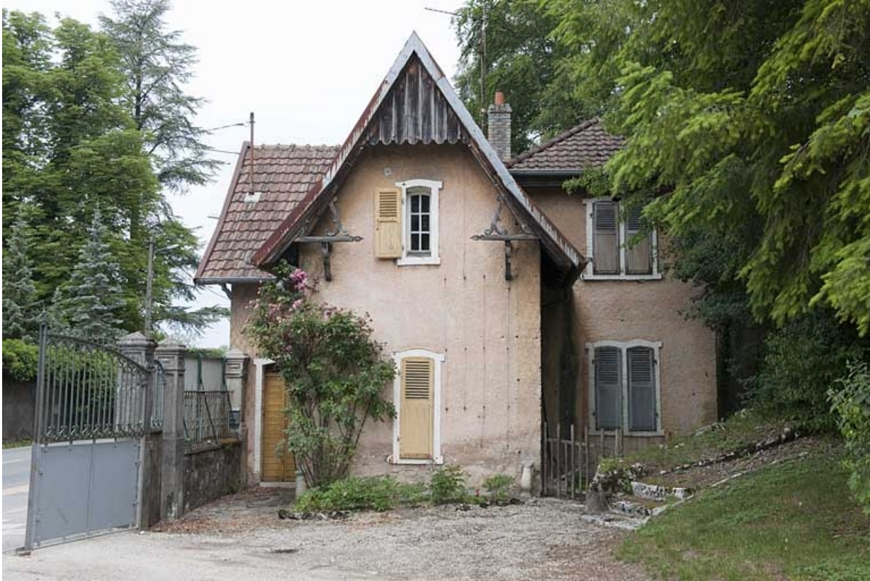
Façade sud de la conciergerie.
