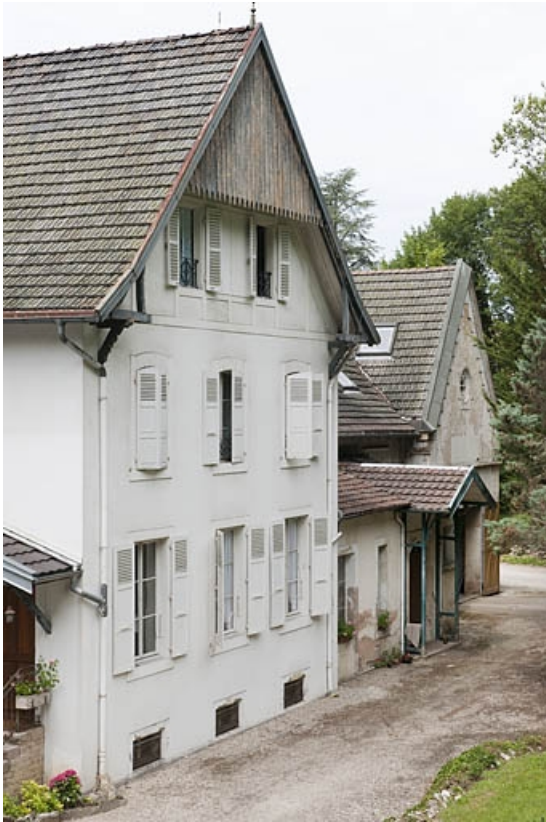
Détail des pignons de la façade postérieure.
