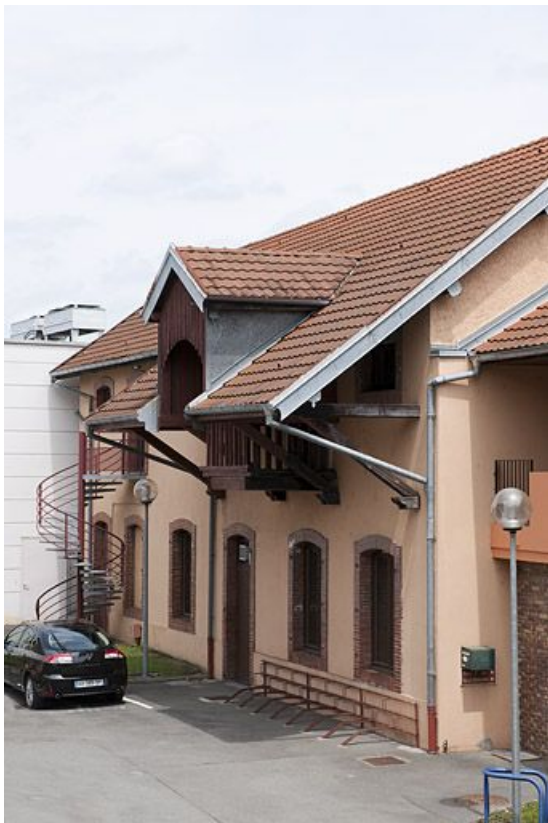
Façade des magasins de stockage.
