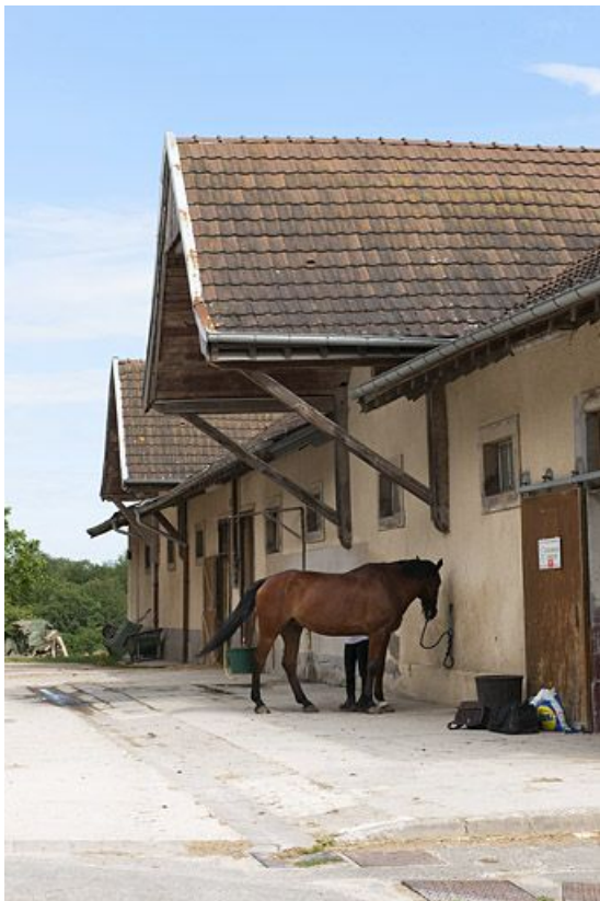
Ancienne étable. Vue de trois quarts.
