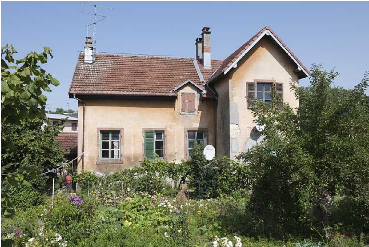
Façade sud de l'école.
