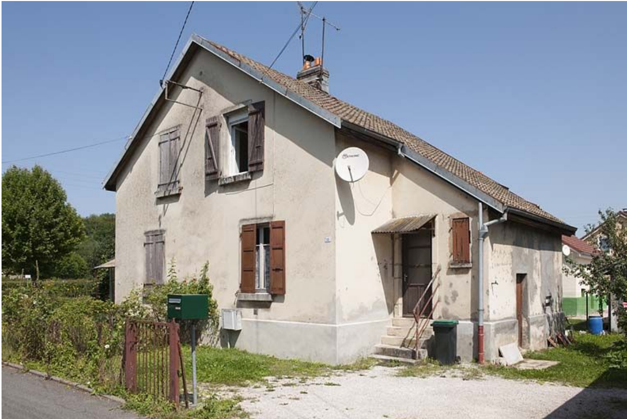
Maison jumelée vue de trois quarts droite.
