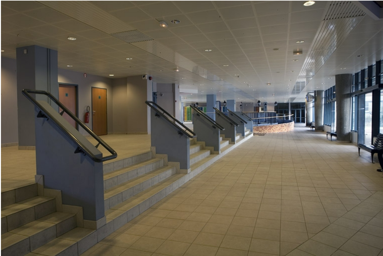
Bâtiment A. Vue du hall d'accueil.
