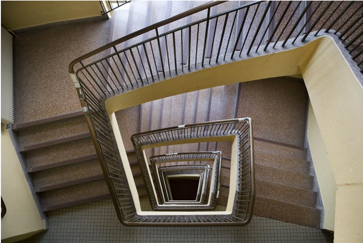
Bâtiment D : internat. Vue plongeante de l'escalier.
