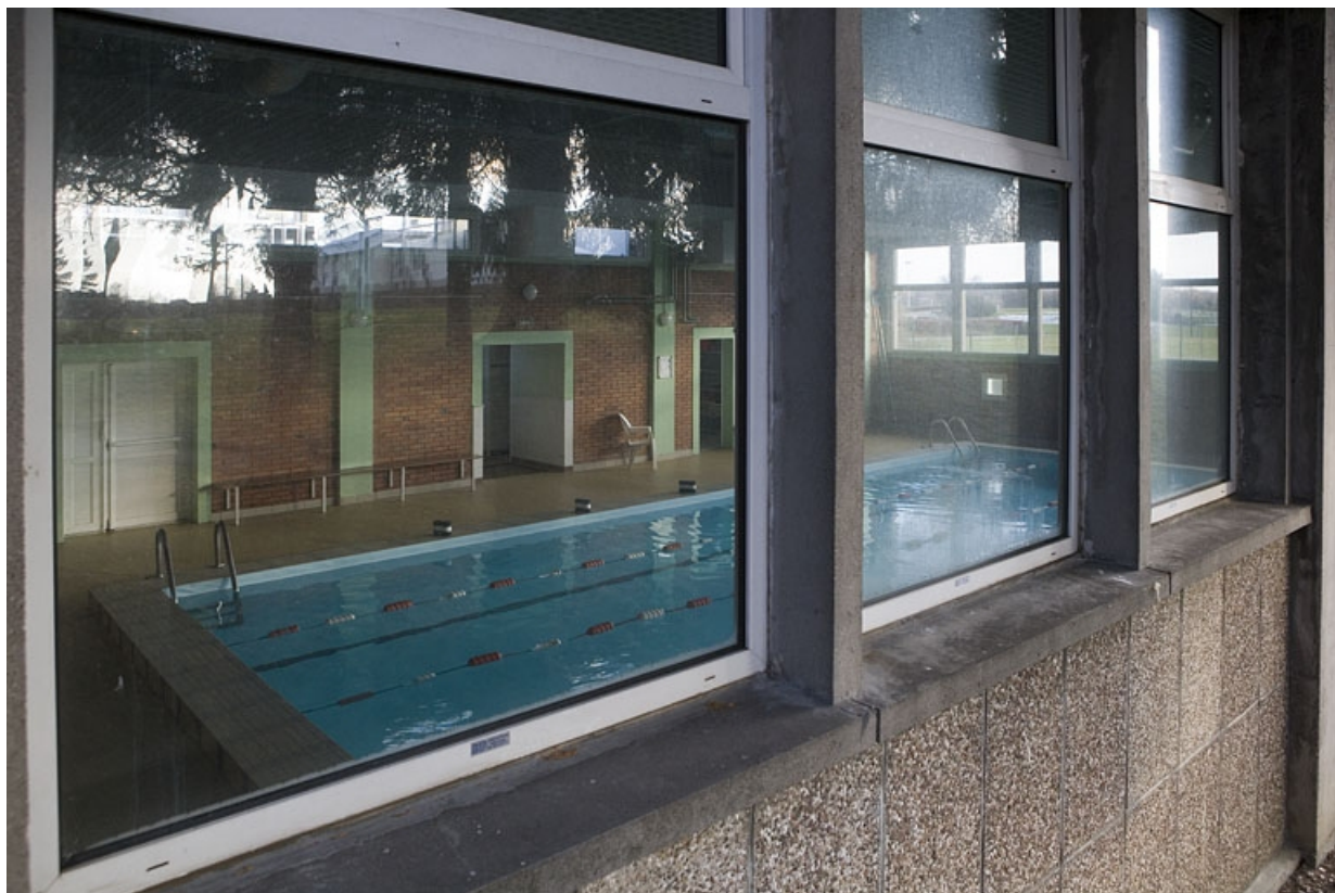
Bâtiment G. Vue piscine.
