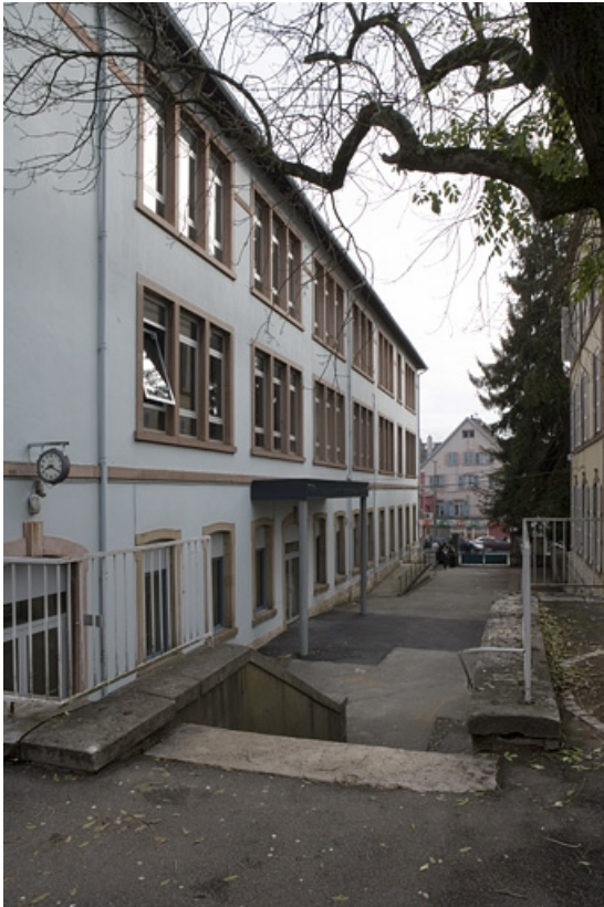
Bâtiment B. Vue face latérale droite.
