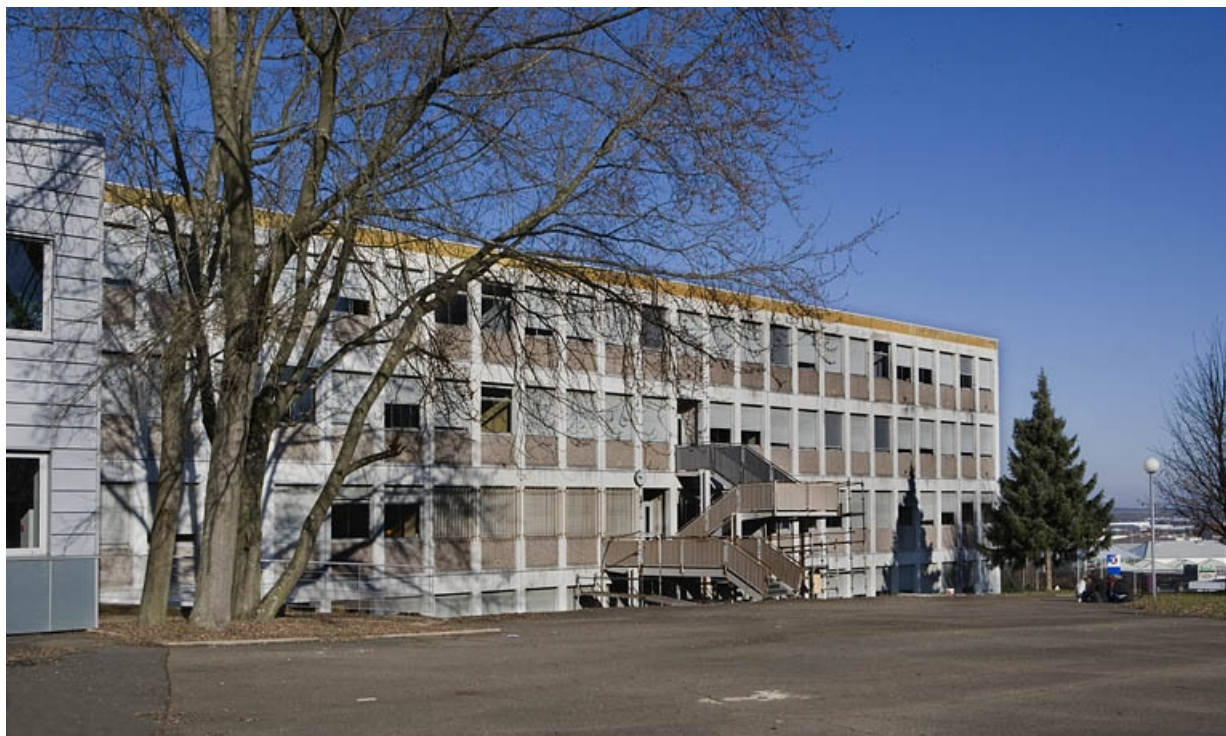
Bâtiment C. Vue de la façade antérieure.
