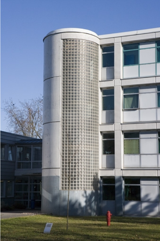
Bâtiment B. Détail de la travée d'escalier.
