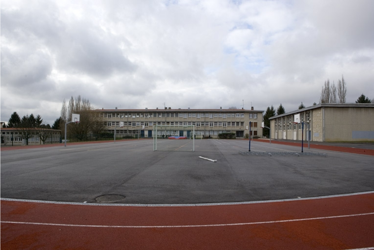
Vue d'ensemble bâtiment F2 et C.
