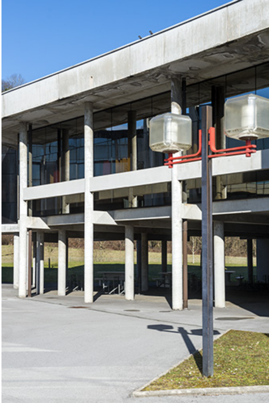
Détail de préau sous le bâtiment d'accueil.
