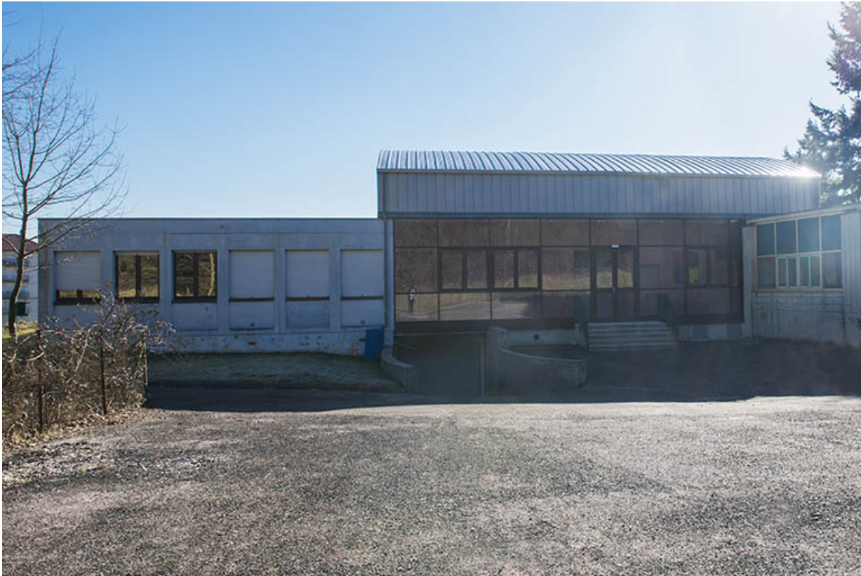
Façade nord-ouest de l'atelier
