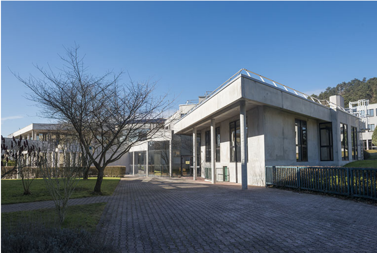
Angle nord-est de l'administration et façade est.
